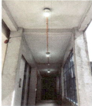
Foto 1: Instalación de tres unidades de luz y un tomacorriente
