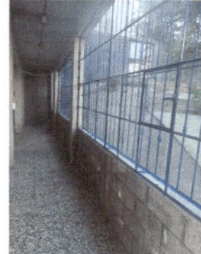
Foto 4: Sustitución de ventanas por metal con vidrio
