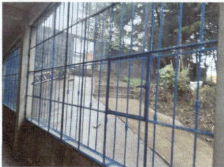
Foto 5: Sustitución de ventanas por metal con vidrio
