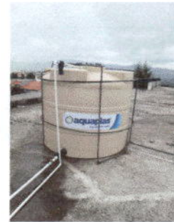
Foto 6: Sustitución de deposito de agua
