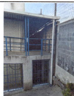
Foto 4: Mejoramiento muro perimetral lado sur
