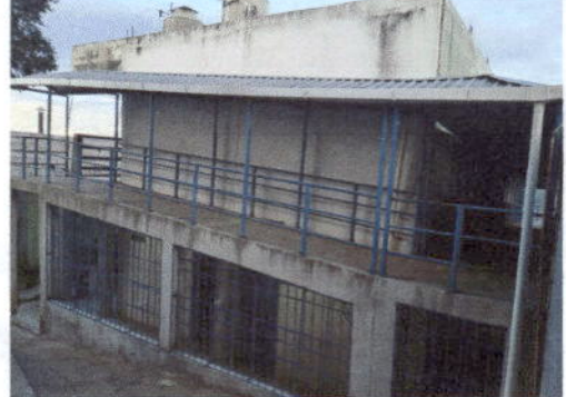
Foto 2: Sustitución y bajada de agua
