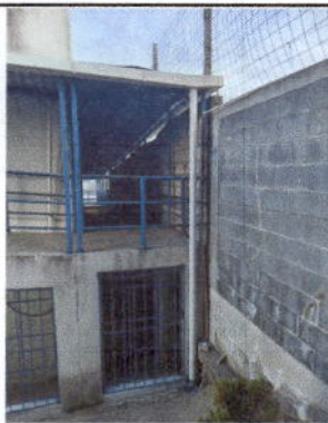
Foto 3: Mejoramiento muro perimetral lado sur
