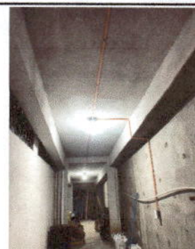
Foto 6: Instalación de dos unidades de luz y un tomacorriente
