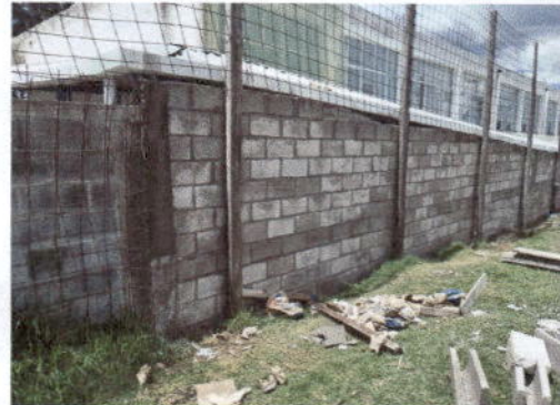
Foto 2: Mejoramiento muro perimetral lado sur
