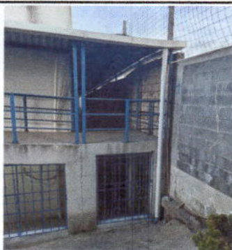
Foto 5: Sustitución de ventana por metal con vidrio
